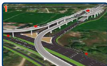
จุดกลับรถใต้ทางแยกต่างระดับบริเวณใกล้กับจุดเริ่มต้นโครงการ
